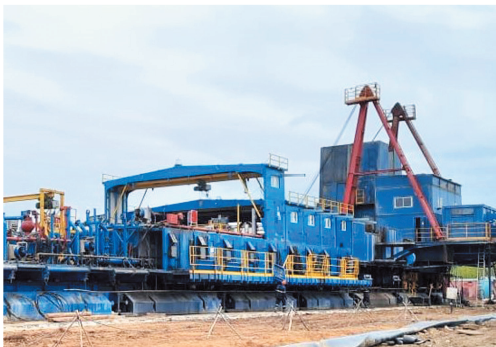
Монтаж эшелона буровой установки на скважине № 124
