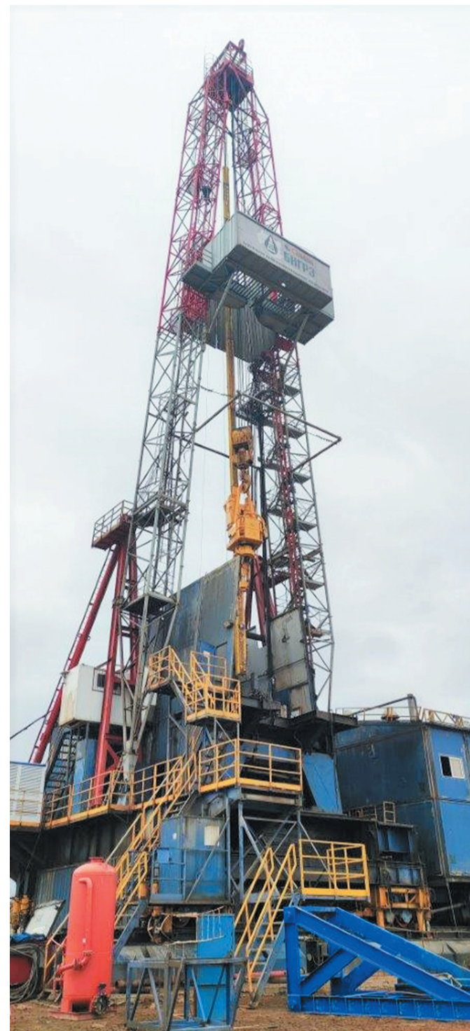
Буровая установка на скважине № 124. Куюмбинский лицензионный участок
